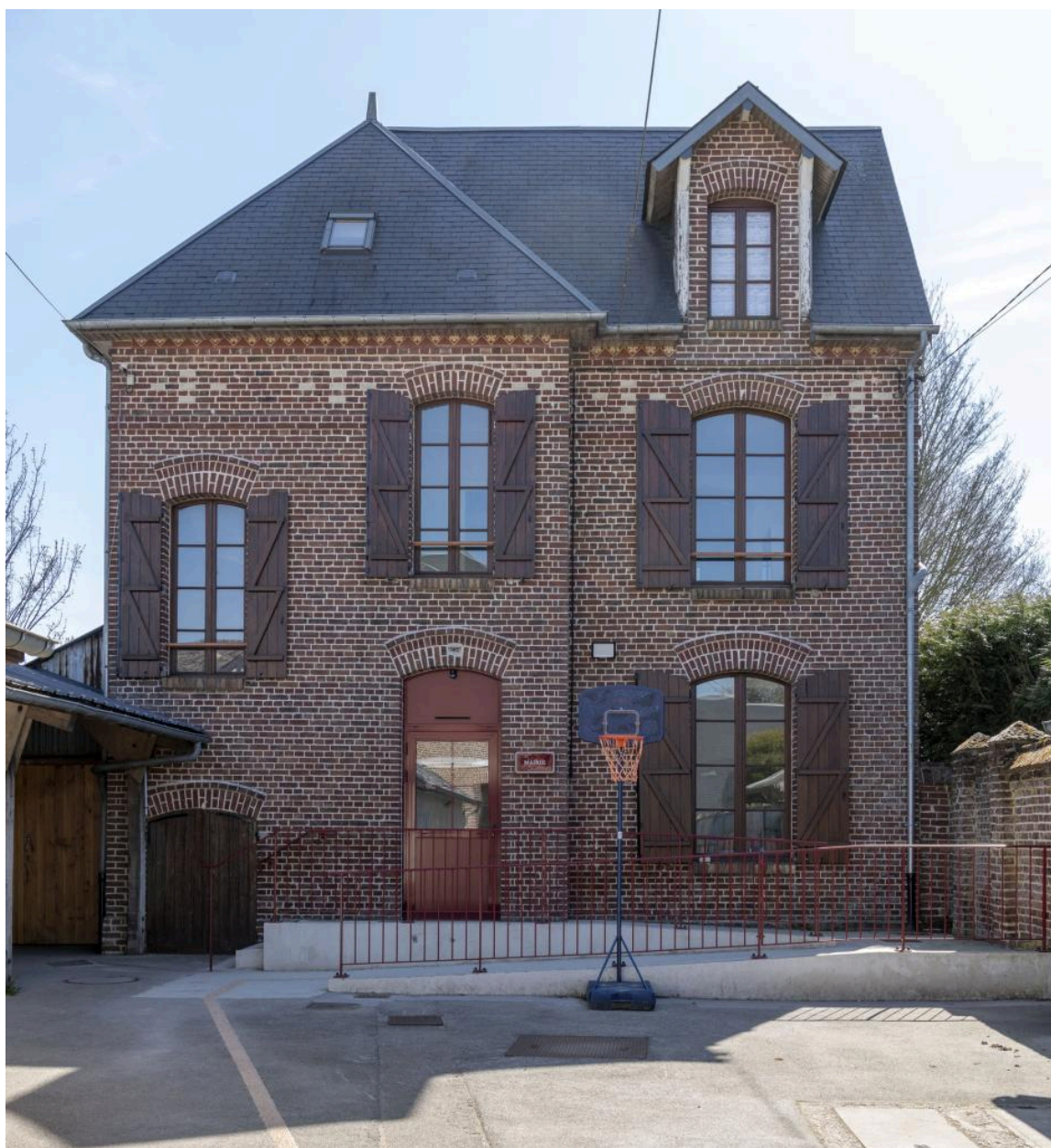
Ancien logement de l'instituteur, fond de cour de l'école, façade nord.
