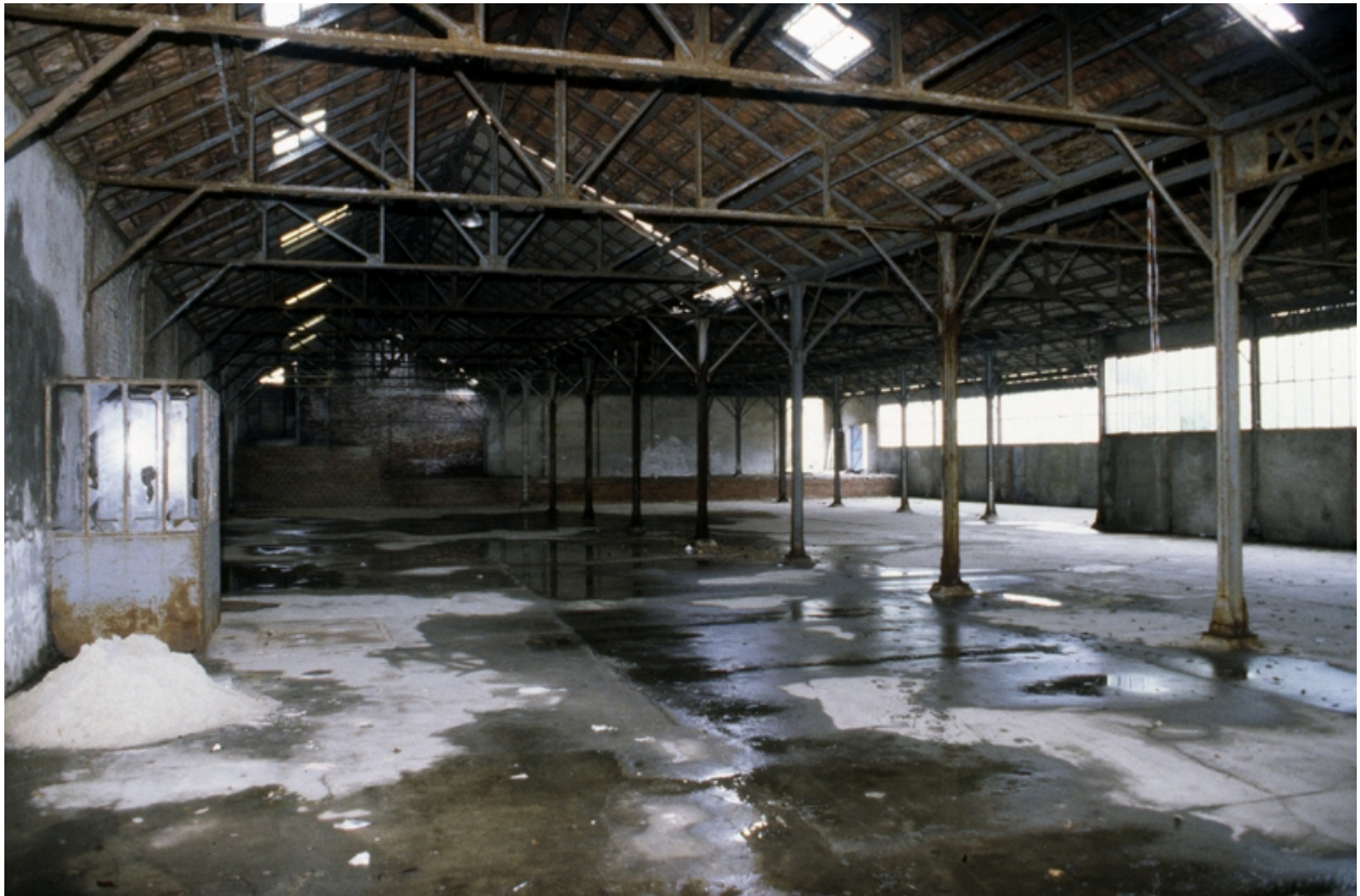
Intérieur du hangar à balles de coton (rue de la Grange), 2001.
