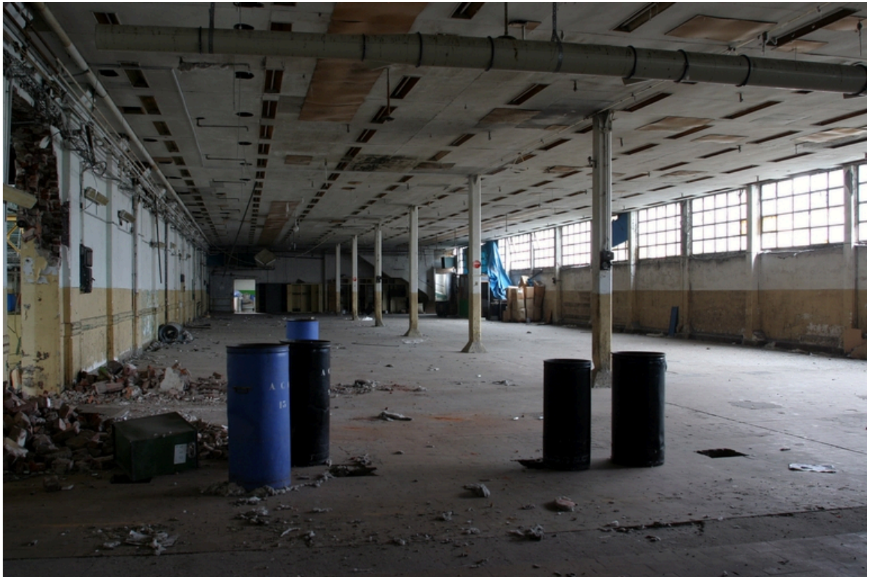
Vue intérieure des ateliers bordant la rue Turbigio.
