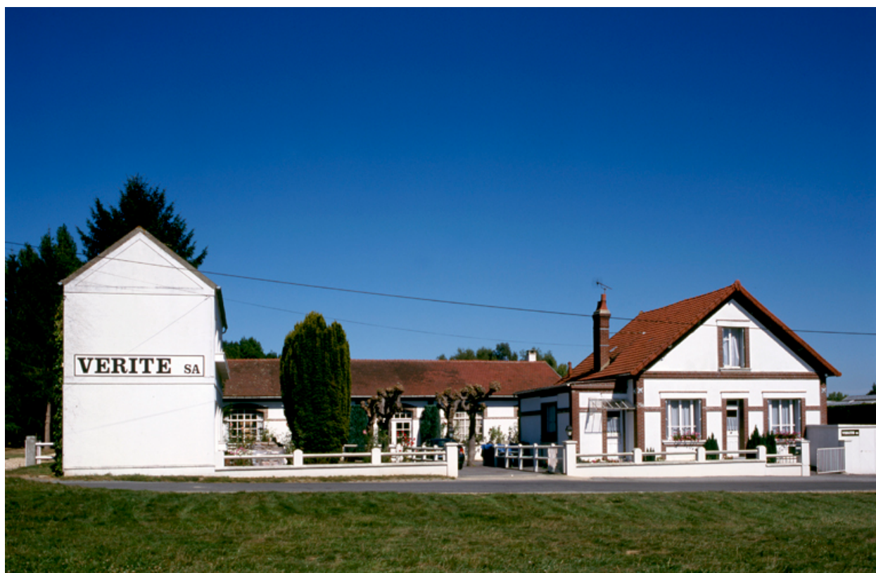
Vue d'ensemble de l'usine.
