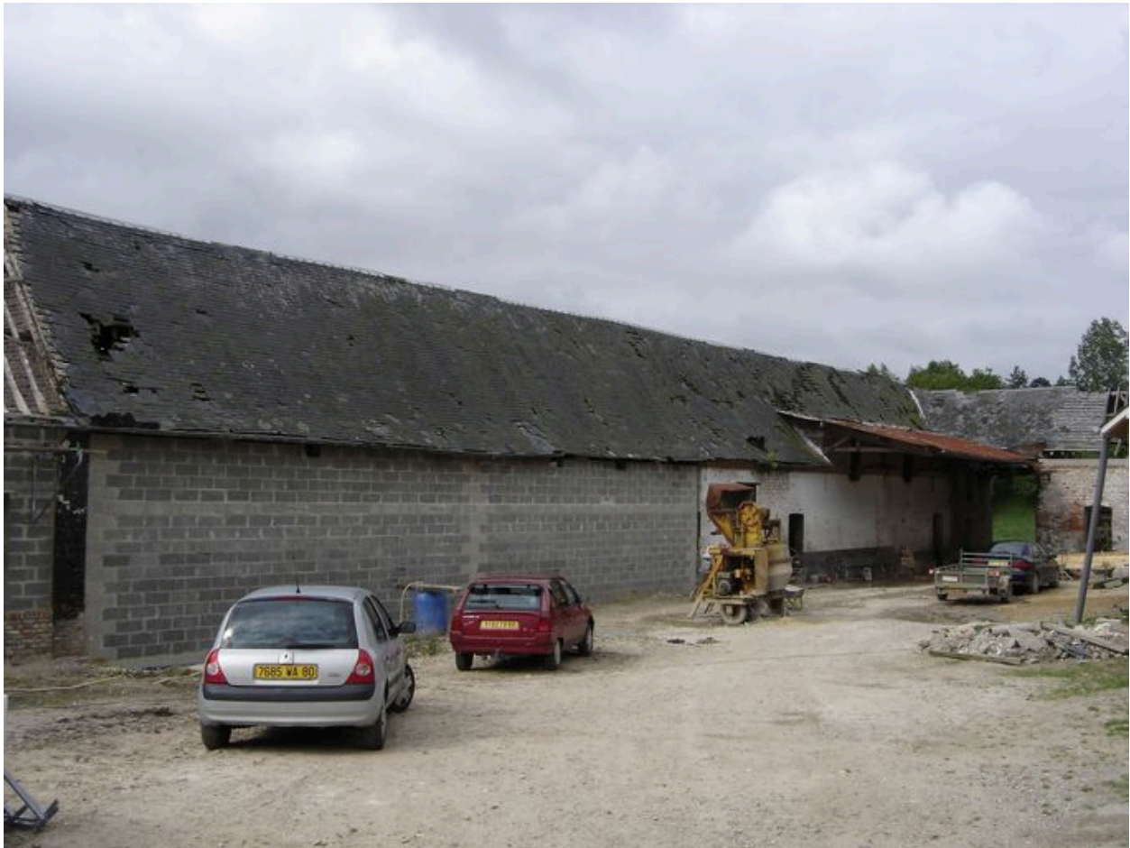
Emplacement des anciens bâtiments agricoles en torchis.
