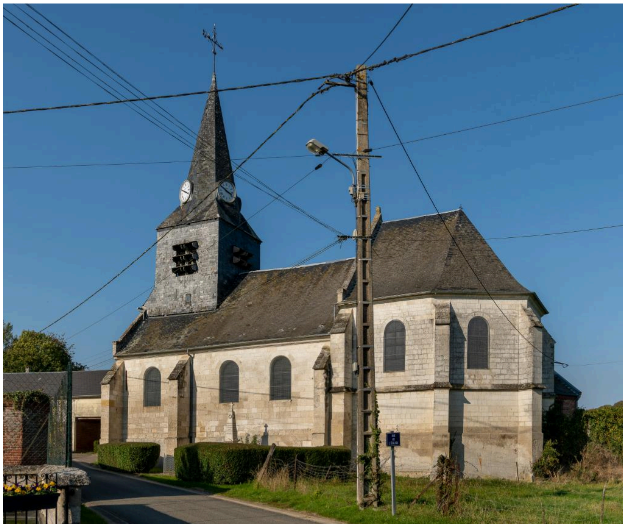
Vue depuis le sud.
