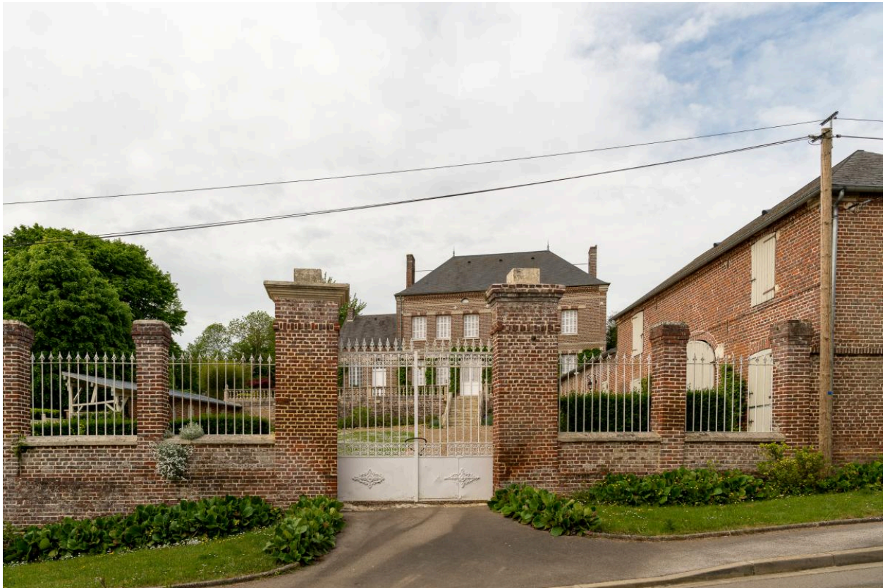
Maison de notable, datée de 1874, n°39 Rue Principale, vue depuis le nord-est.
