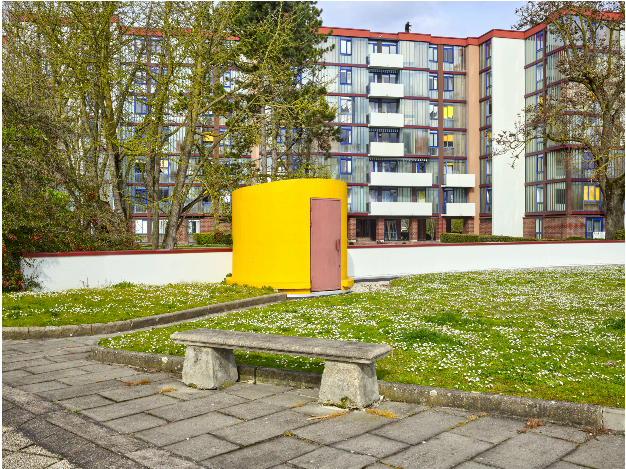
Édicule de sortie de garage et banc sur le toit-terrasse des garages, vue depuis le sud.
