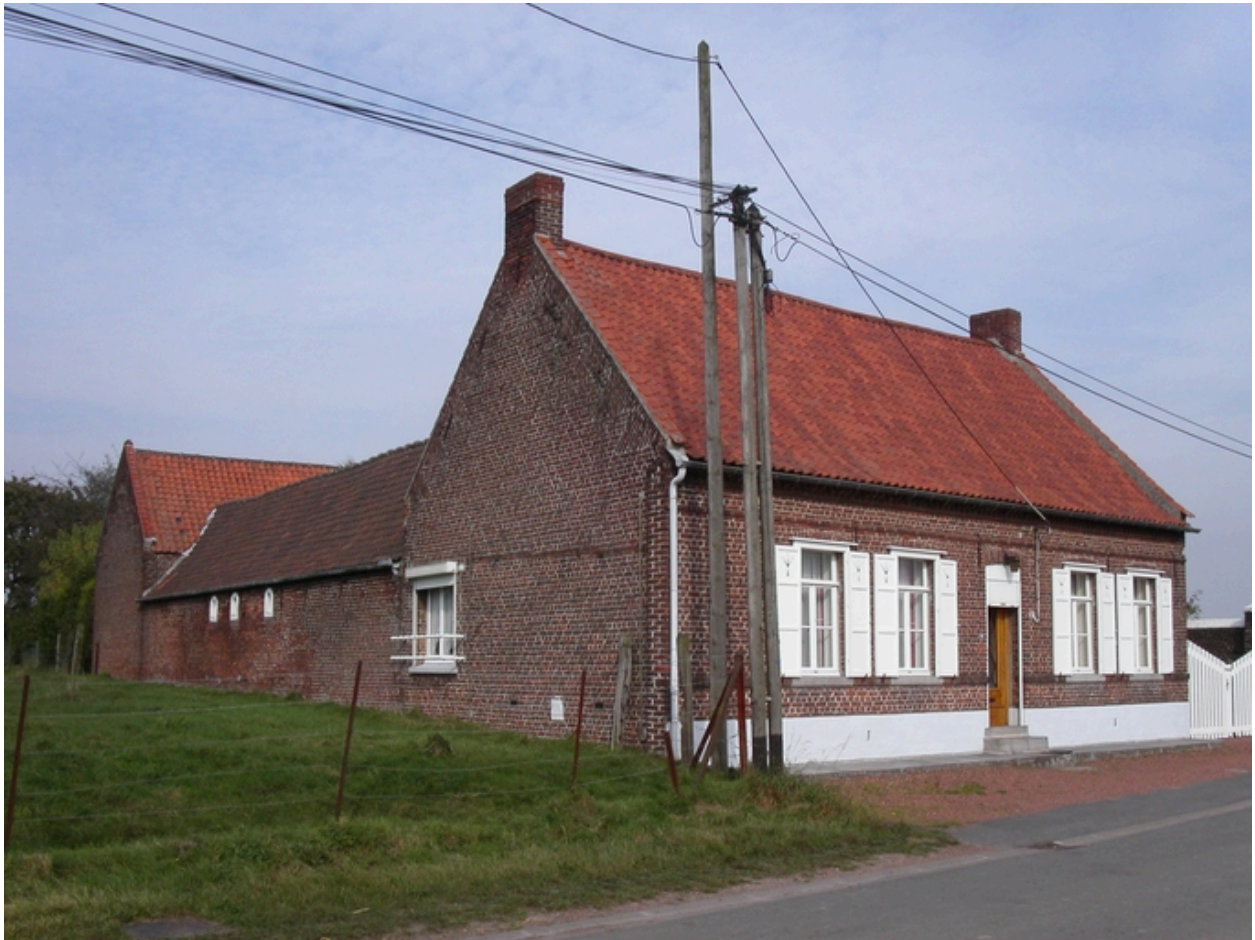
Ferme en U (ouverte latéralement), 982, rue du Hennoy, vue depuis la rue.
