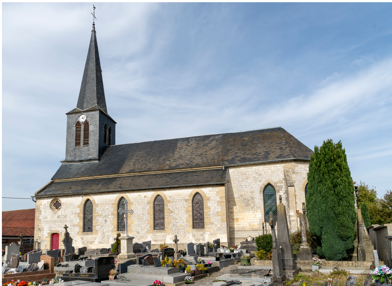
Vue générale de l'élévation sud.
