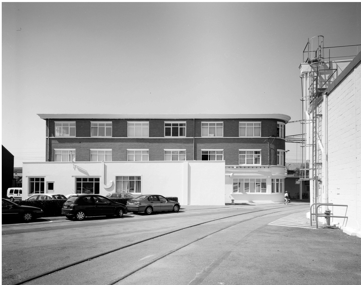
Vue générale des anciens bureaux de l'usine Sambre et Meuse, actuellement propriété de la Ville de Jeumont.
