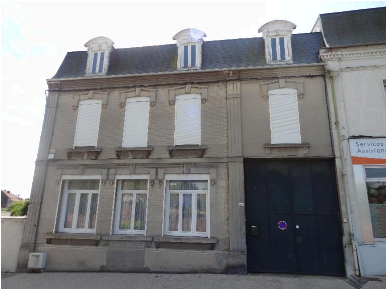
Ancien logement patronal.
