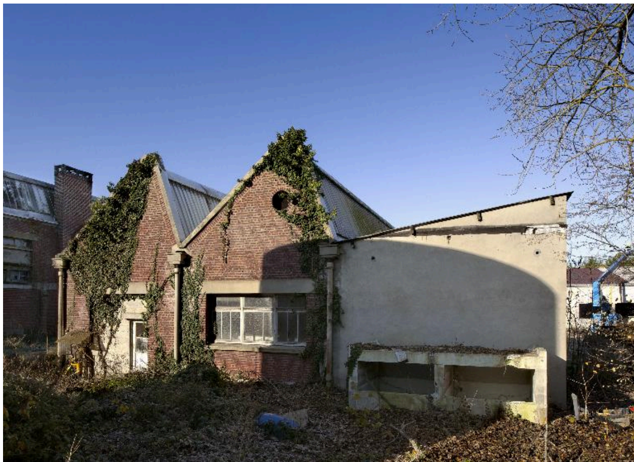
L'atelier de menuiserie, façade sud.
