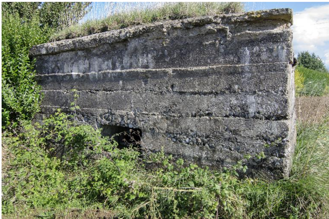
Sortie du canon, élévation nord-ouest
