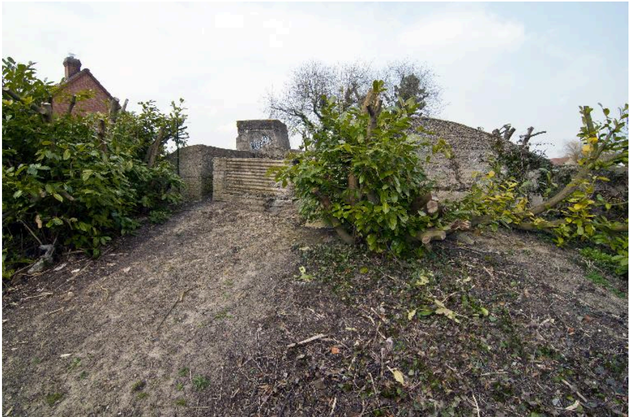
Vue générale, vers le nord (au grand angulaire)
