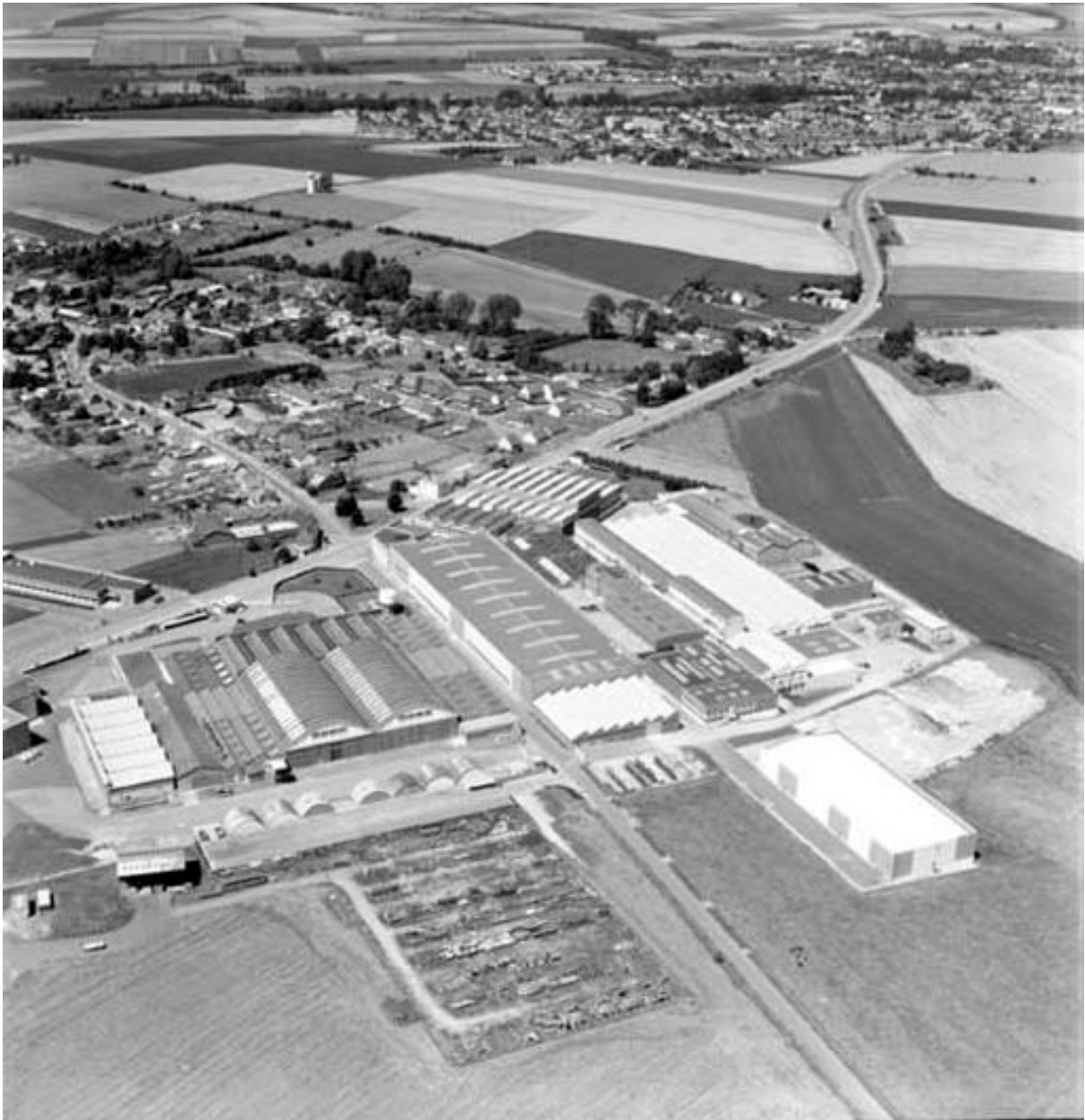
Vue aérienne, flanc sud-est.
