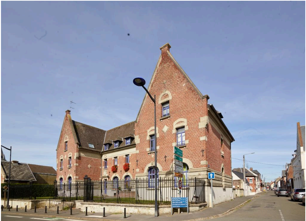
Façade principale et façade latérale droite vues depuis la rue de la République.
