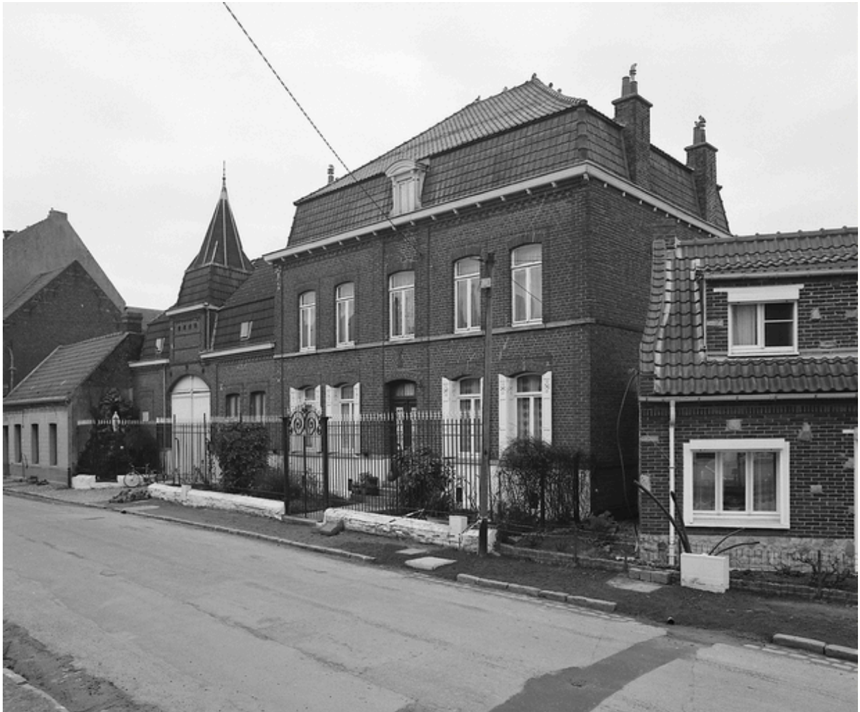
Ferme, 51-59, rue de l'Eglise.
