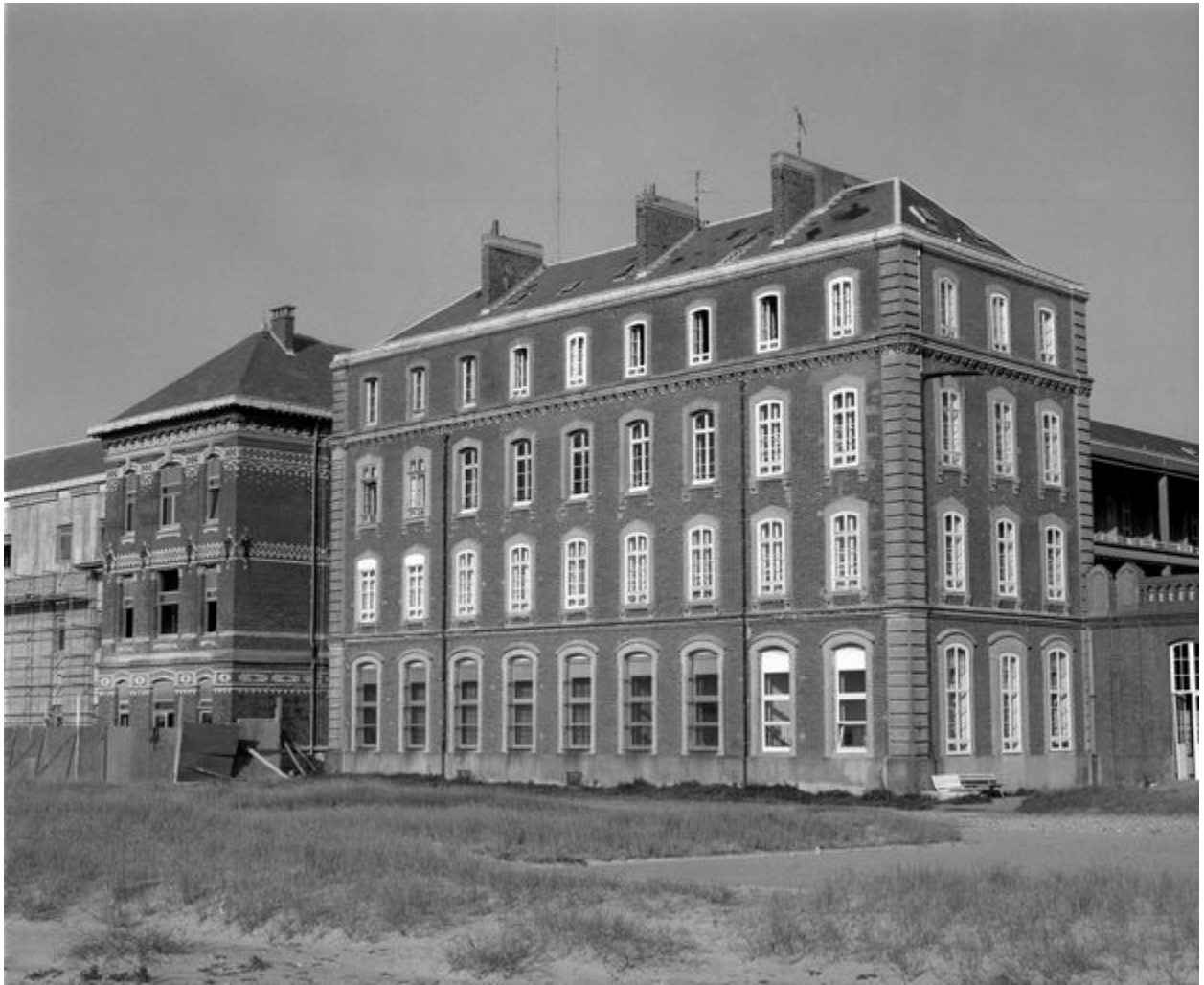
Corps de logis principal, élévation antérieure, détail du pavillon nord, vue de trois-quart droit.
