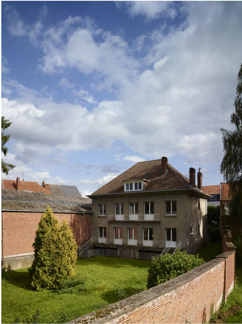
Maison, 14 rue Achille Carlier : vue générale de la façade arrière.
