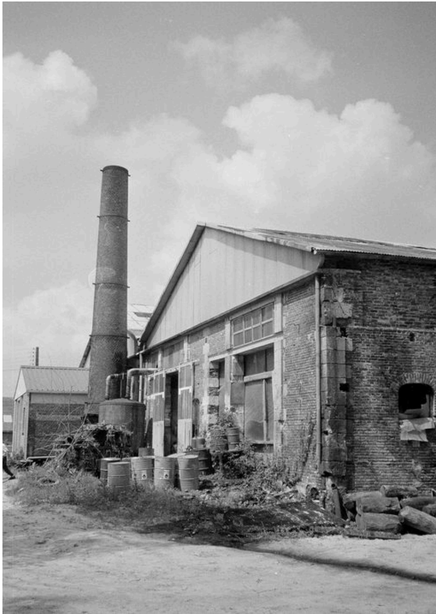
Atelier de fabrication, flanc est.
