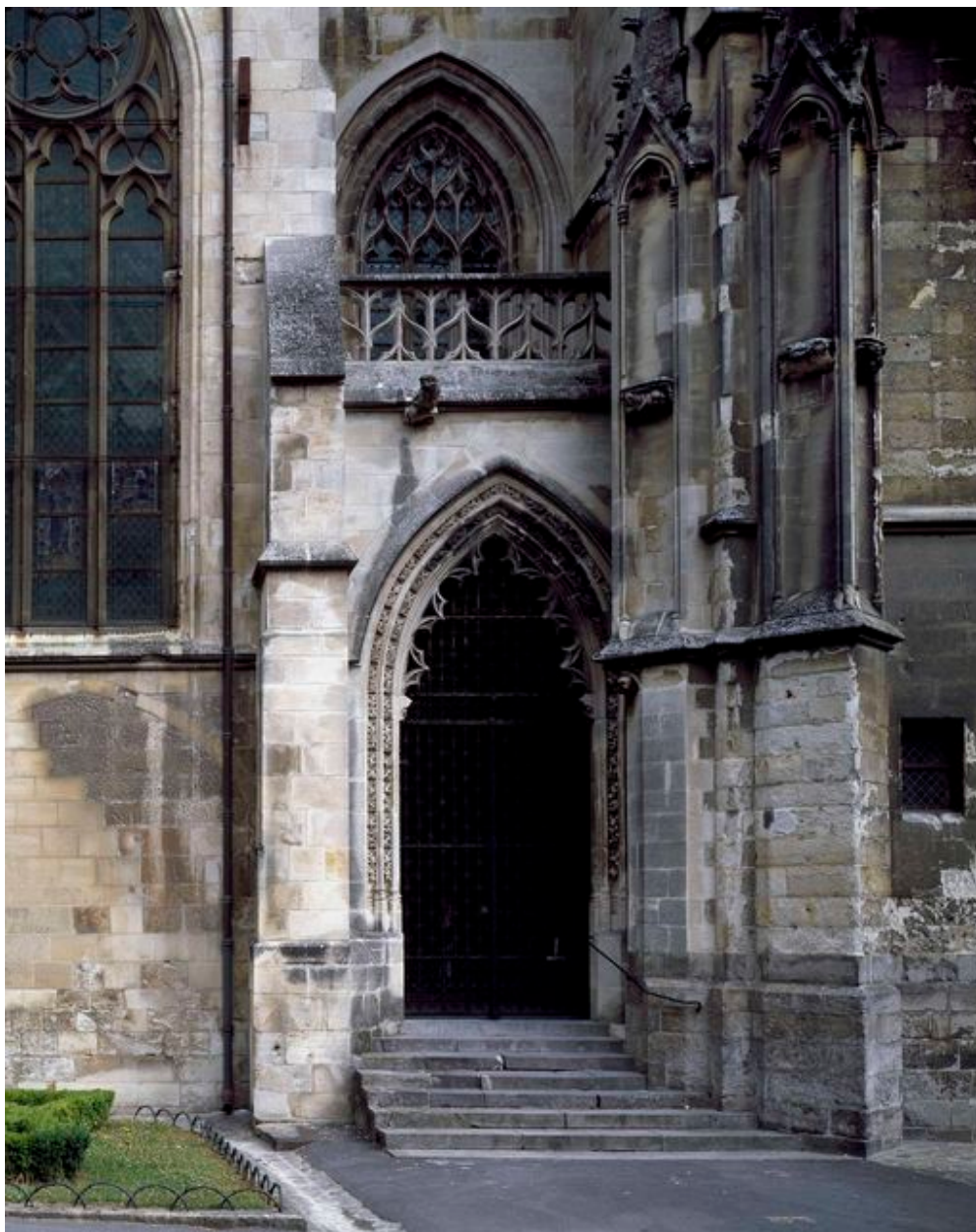
Vue de la première porte.
