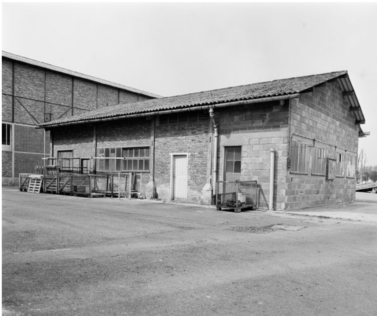
Atelier de réparation, angle nord est.
