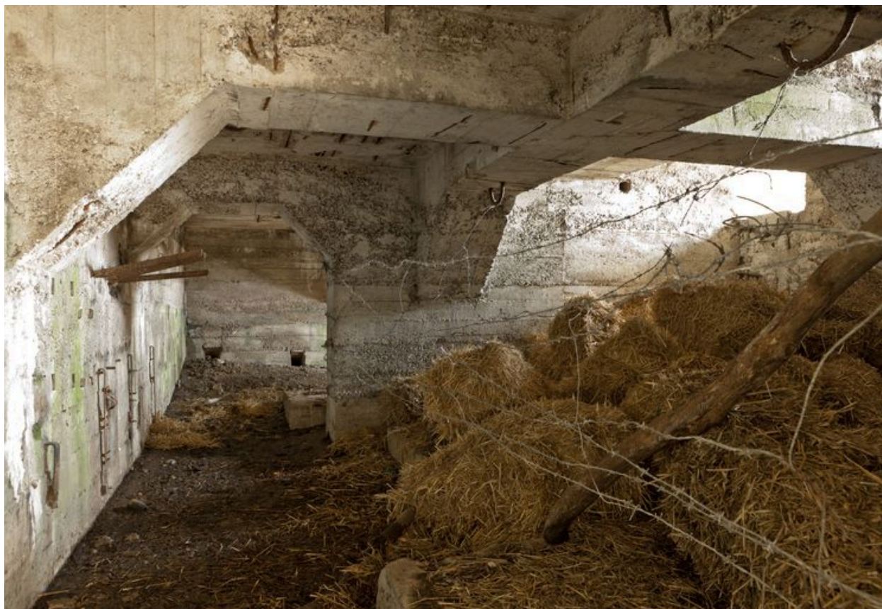
Vue intérieure, vers l'est
