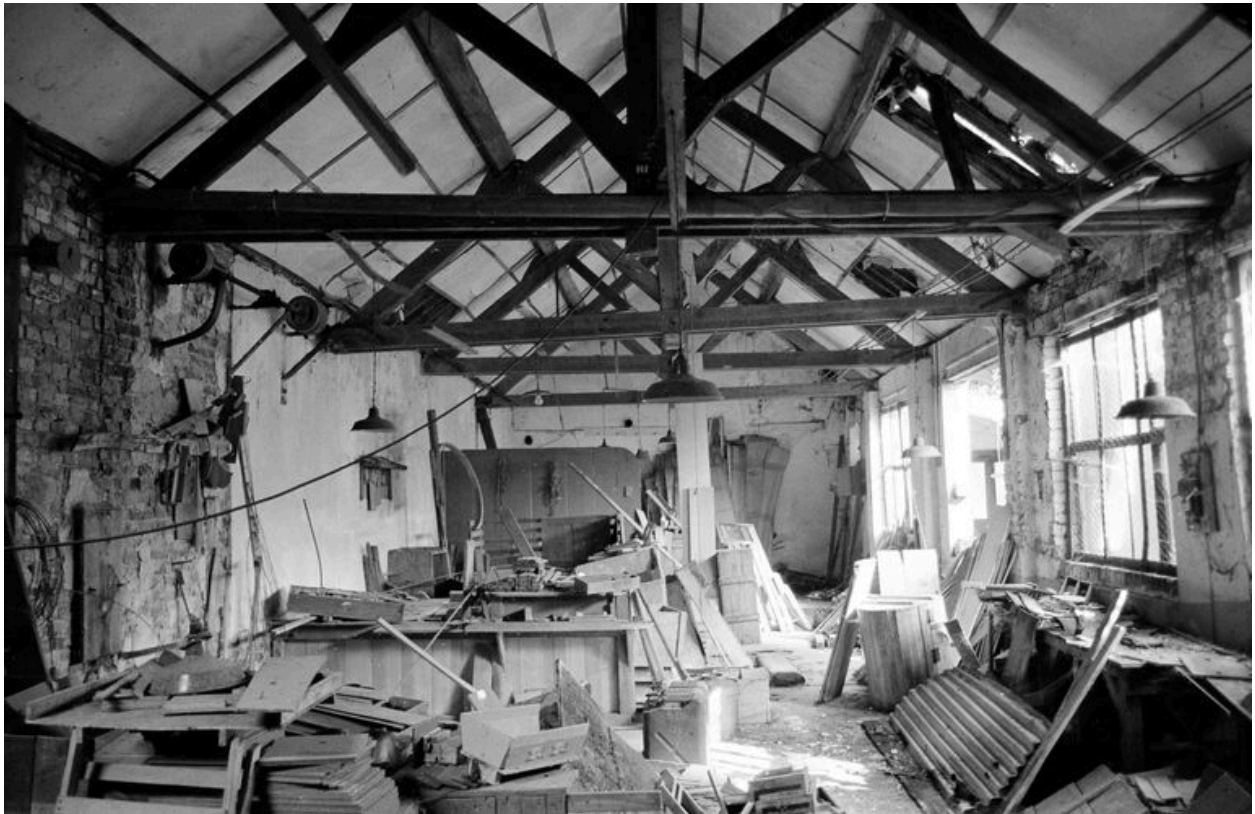
Intérieur du grand atelier de fabrication.
