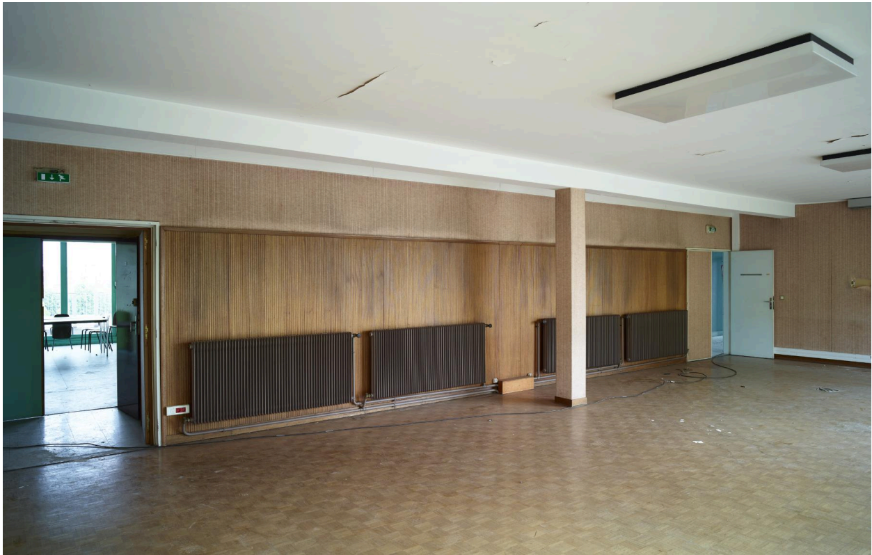
Grande salle du deuxième étage, côté couloir.
