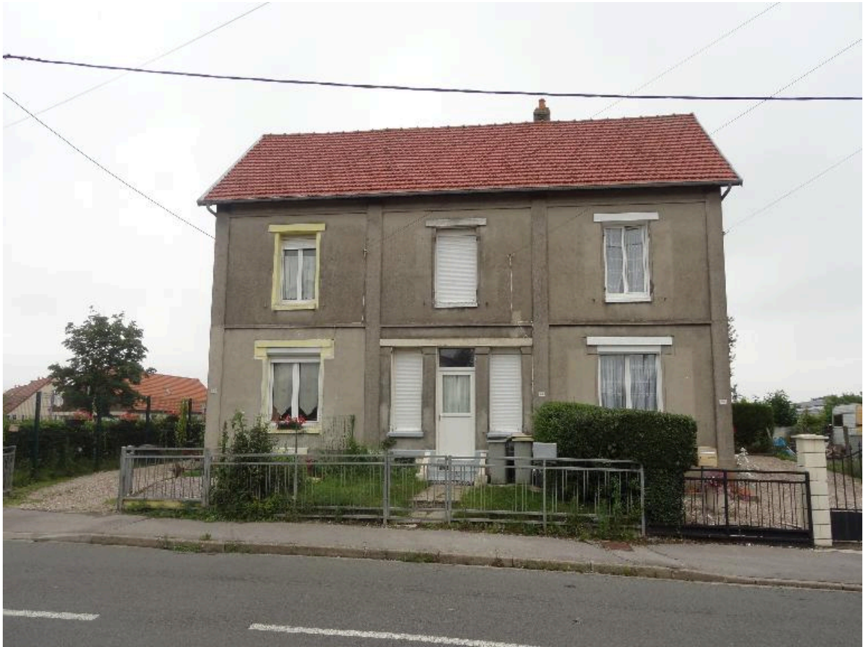
Vue du groupe de logements n°22 au n°24 rue Marieu Briet.
