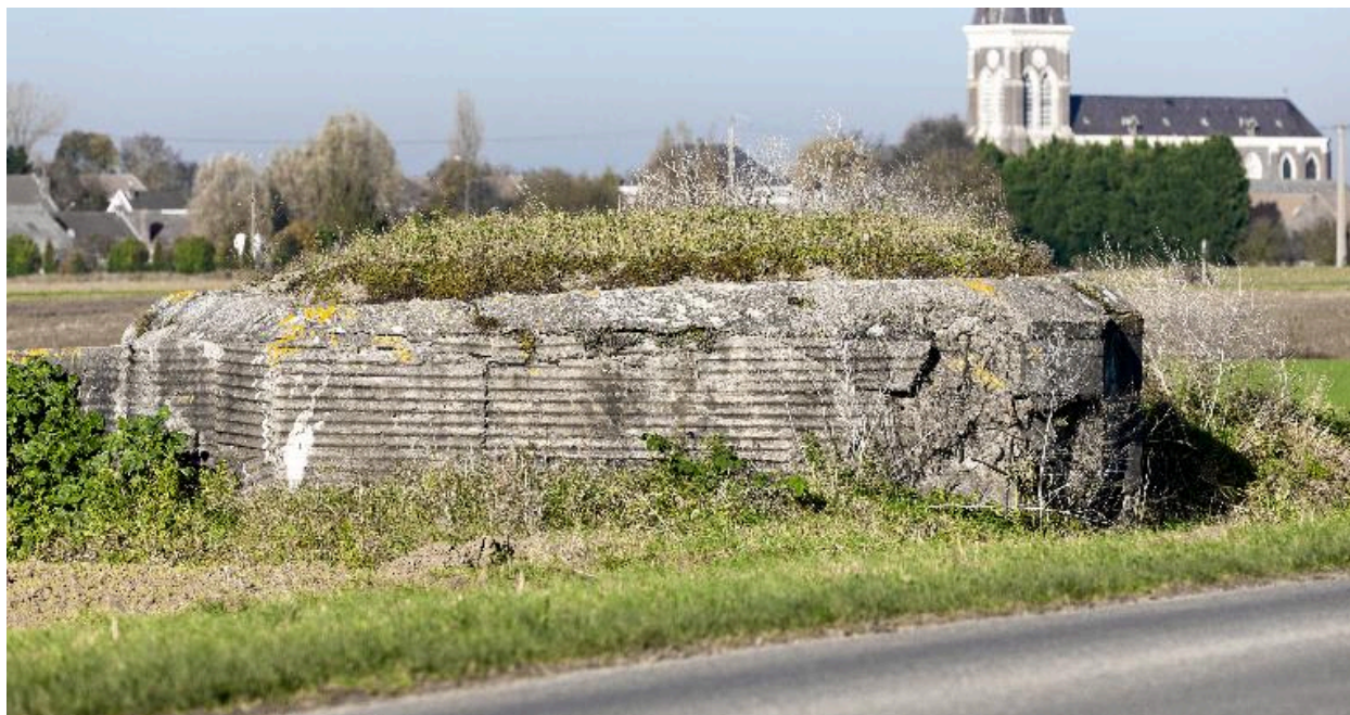
Vue vers le nord-ouest
