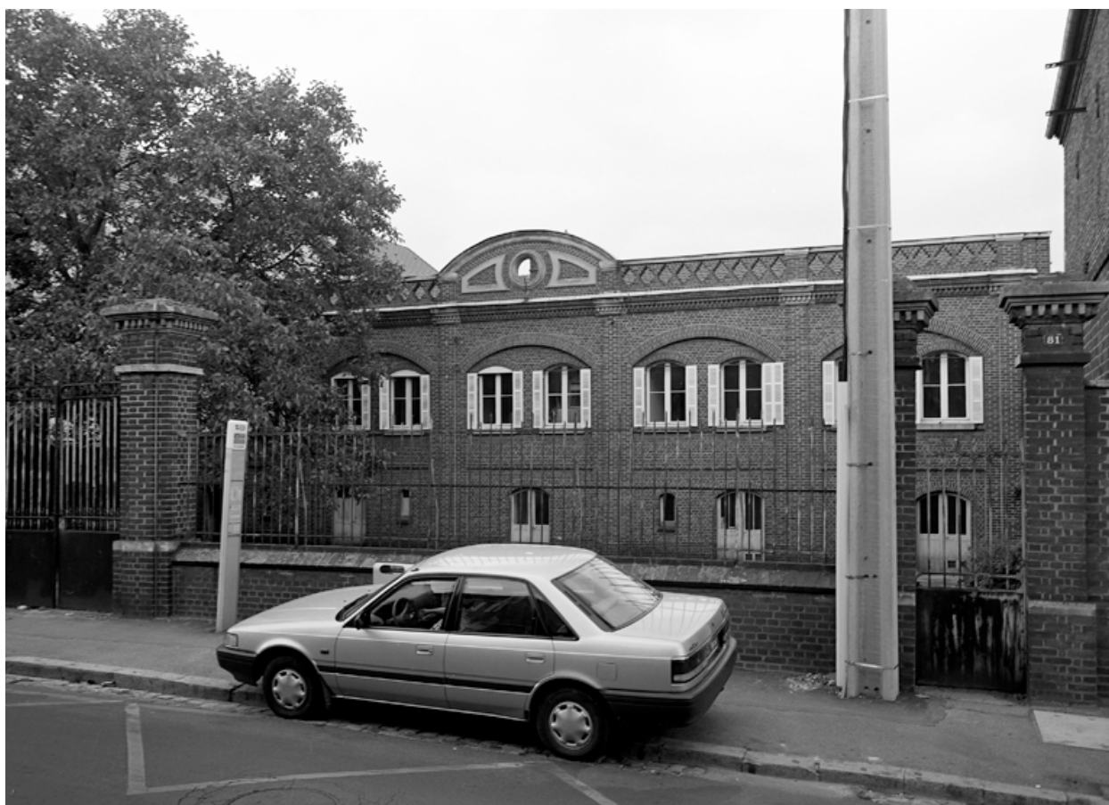
Les logements de contremaîtres, façade sur rue.
