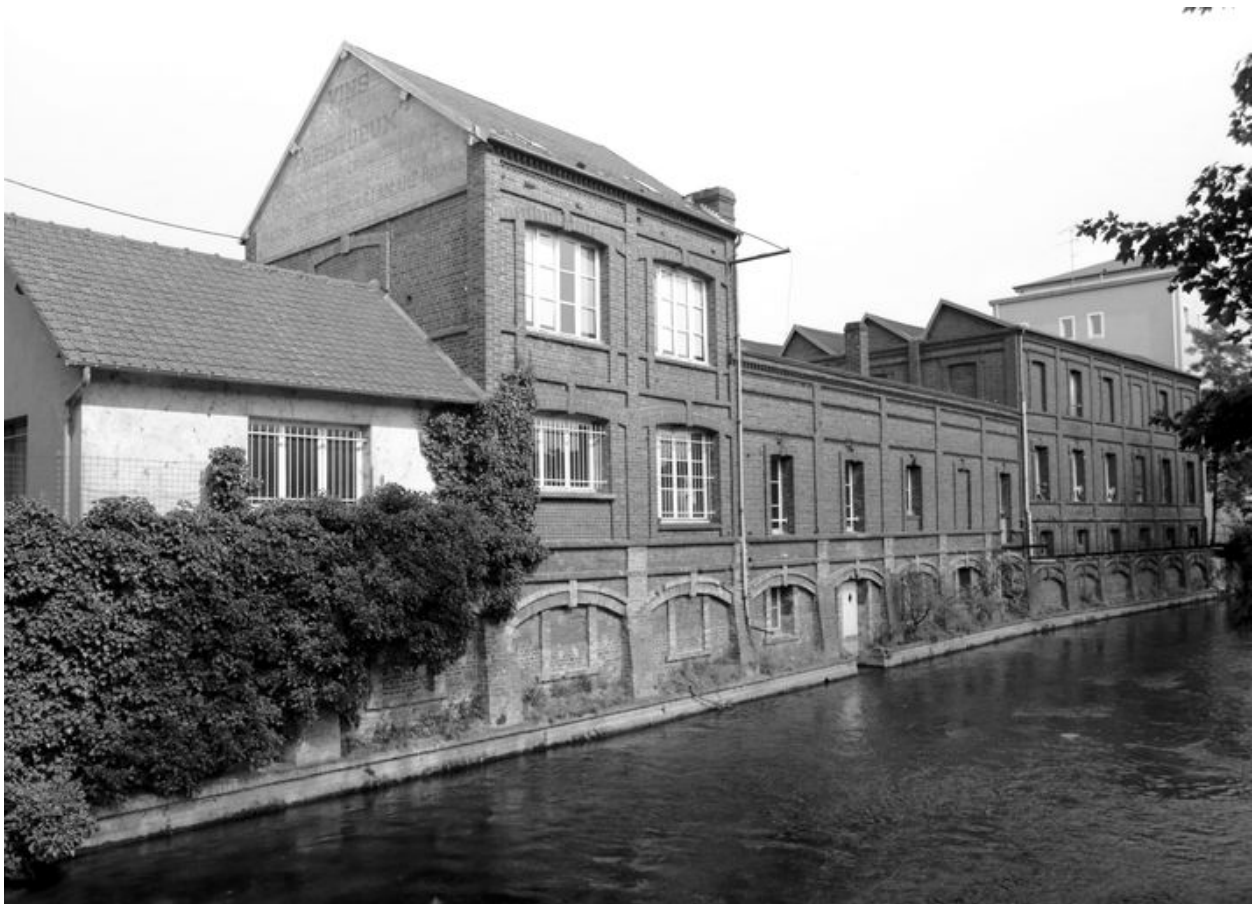
Vue latérale sud de l'usine.
