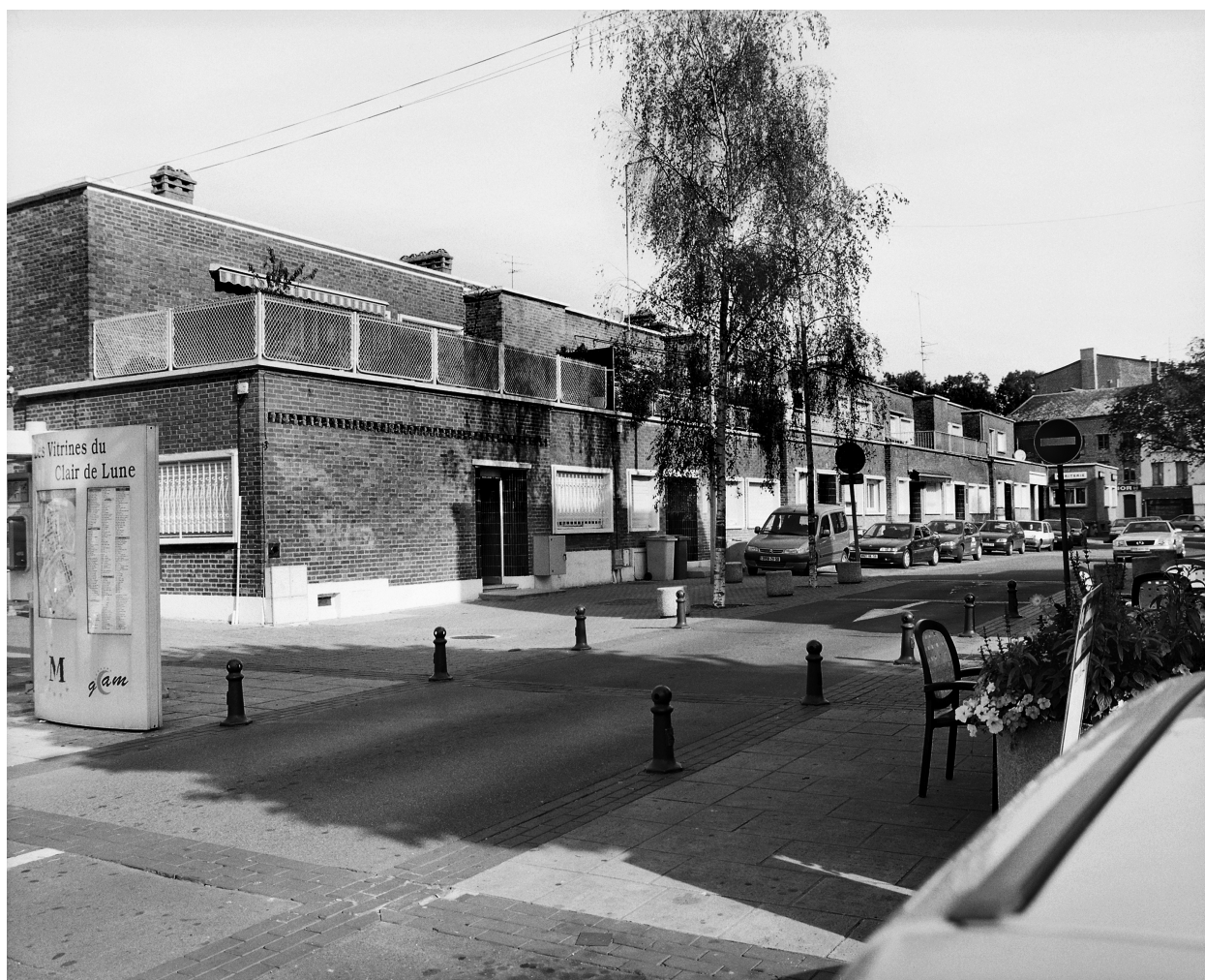
Bloc 3 de l'îlot D : alignement postérieur.
