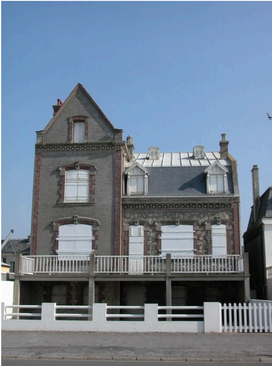
Vue d'ensemble, élévation côté mer.
