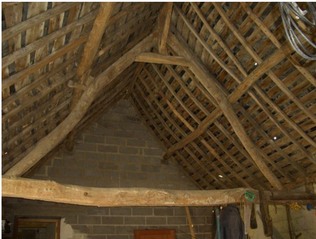
Autre vue d'une ferme de la charpente.
