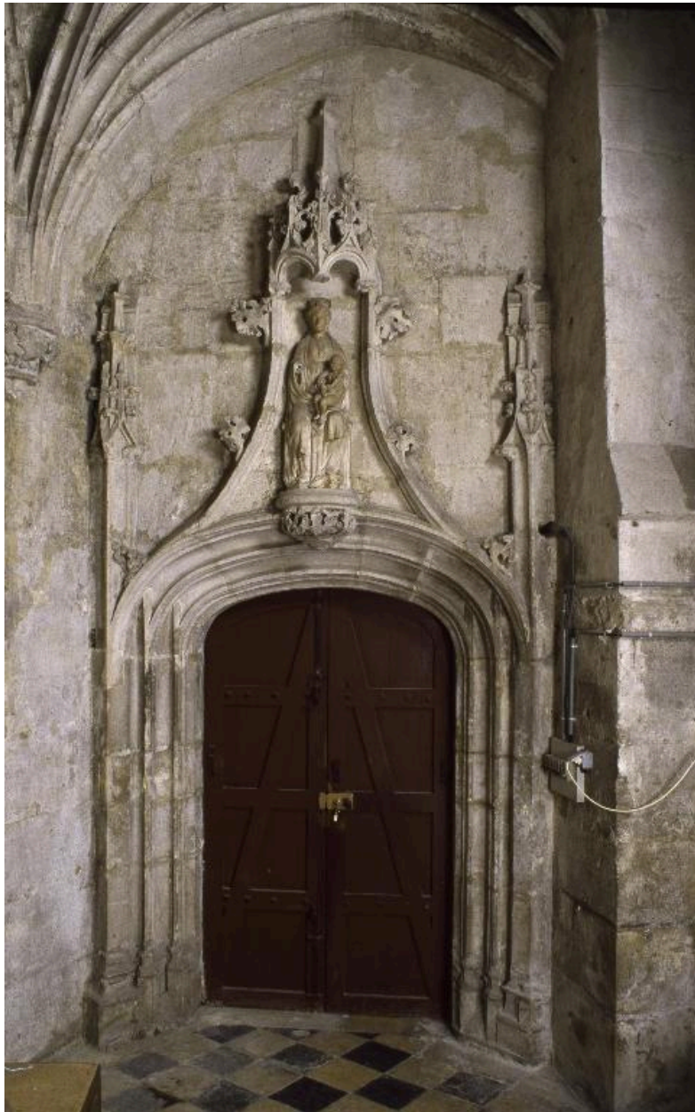
Vue de la porte du couloir qui reliait jadis le collatéral sud du chœur à la sacristie.
