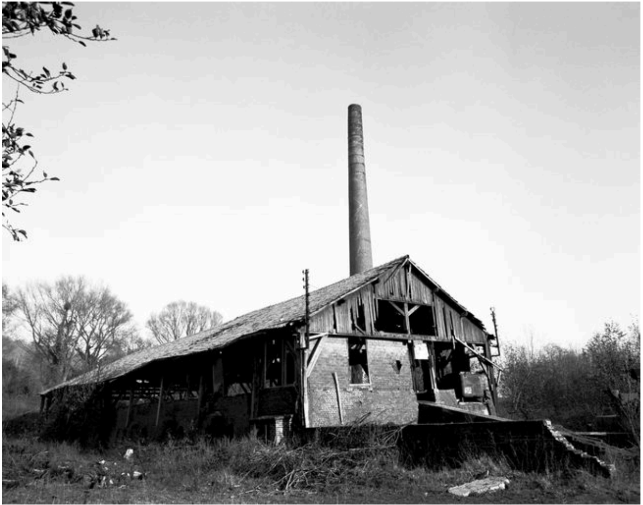
La cheminée d'usine et l'angle sud ouest du four industriel type Hoffmann.
