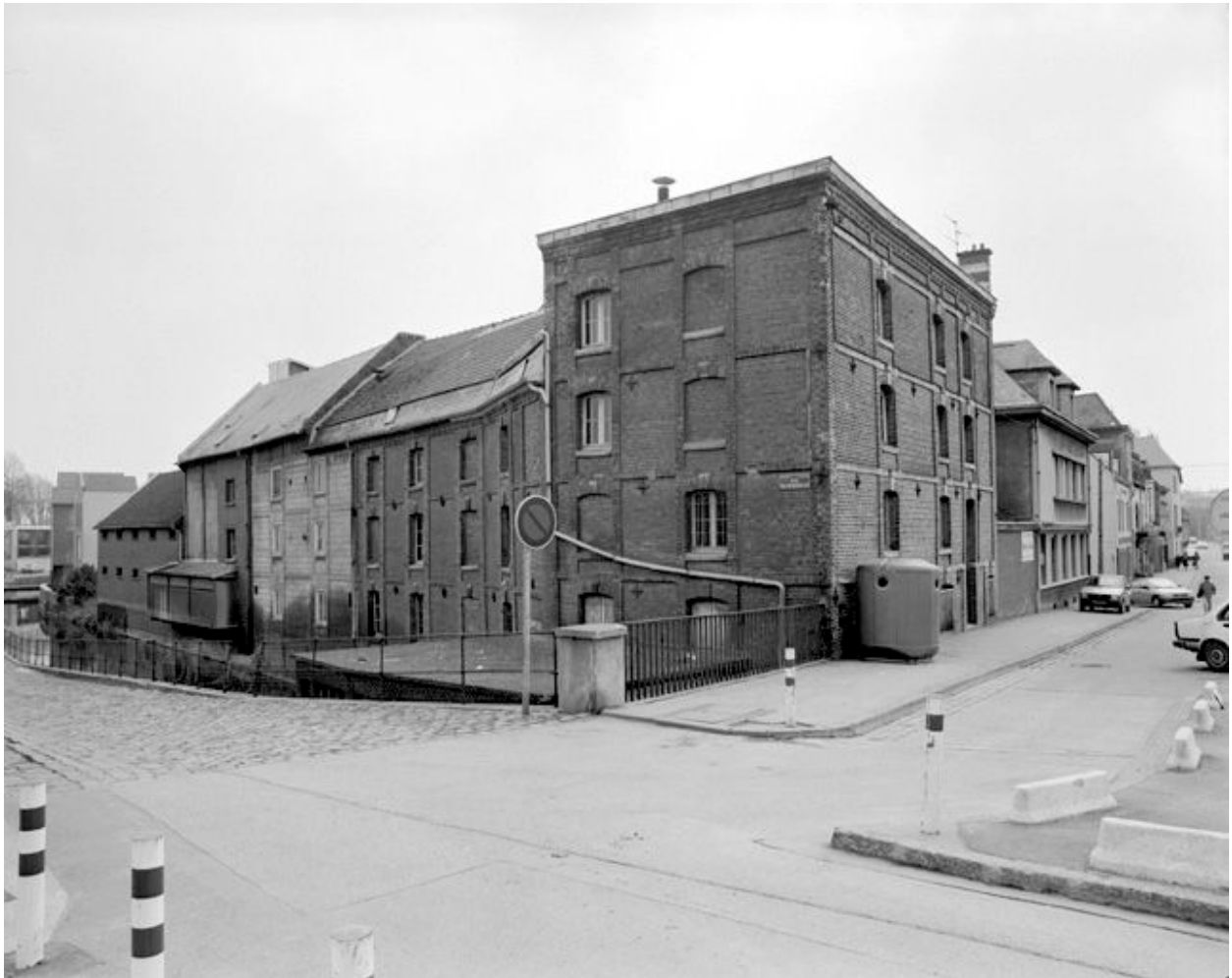
Vue générale, flanc nord-ouest.
