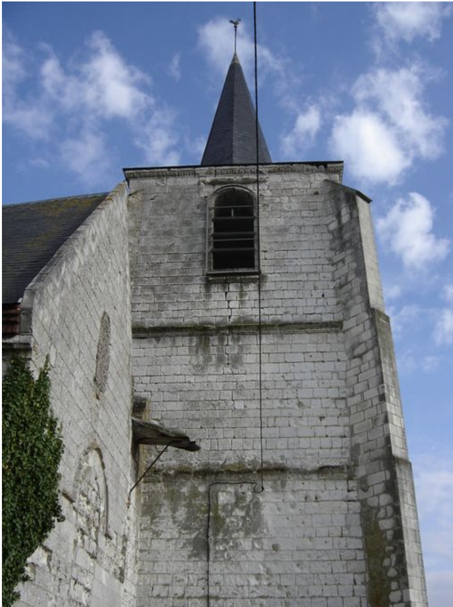
Vue détaillée de la tour.
