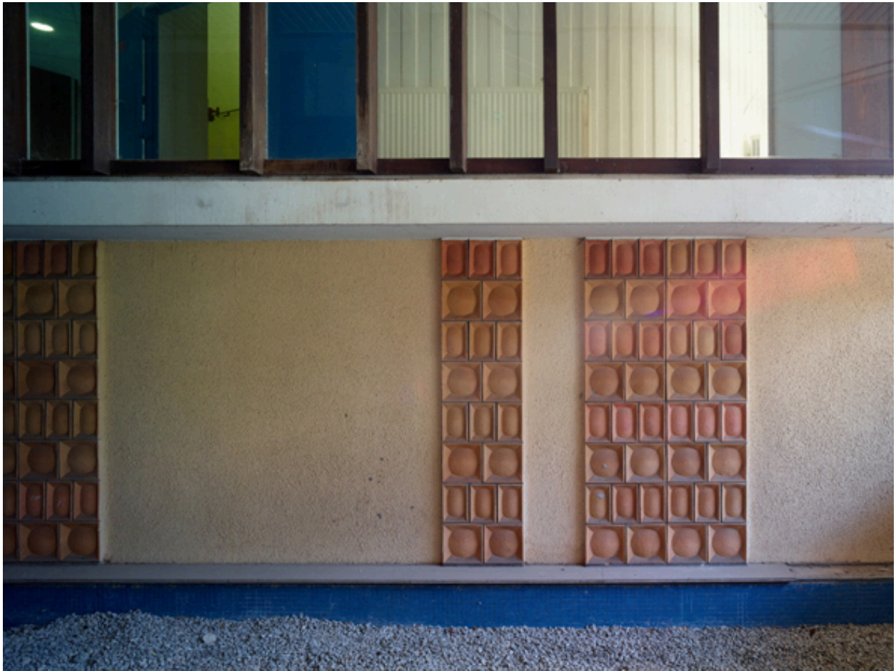
Vue rapprochée des panneaux décoratifs de céramique, situés à l'extérieur du rez-de-chaussée de la tour d'internat, depuis l'ancien patio d'accueil.
