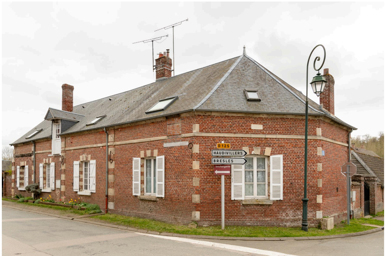
Logis sur rue, 1869, n°15 de la rue du Pont Maréchal, vue prise depuis le nord.
