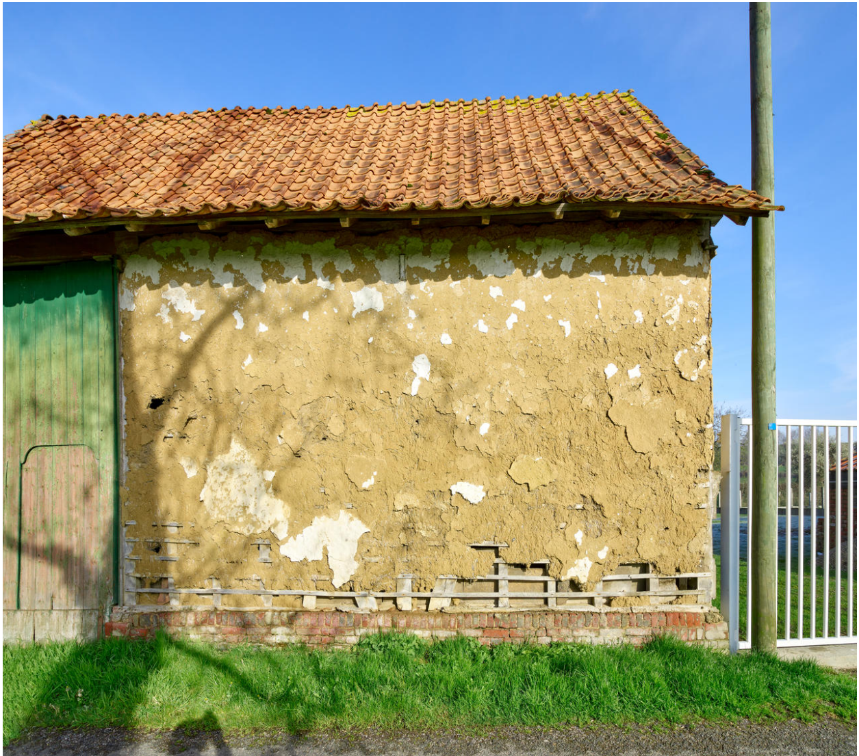
Détail du mur en torchis de la grange.
