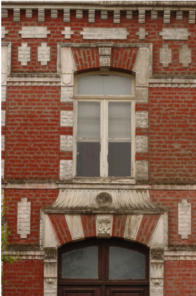
Détail sur la travée centrale.
