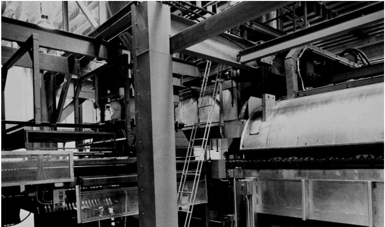
Atelier de fabrication : vue intérieure, vers 1925 (AP).
