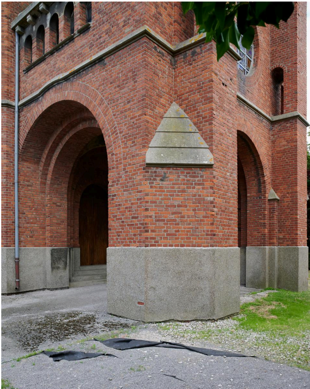
Clocher-porche. Vue depuis le nord-ouest.
