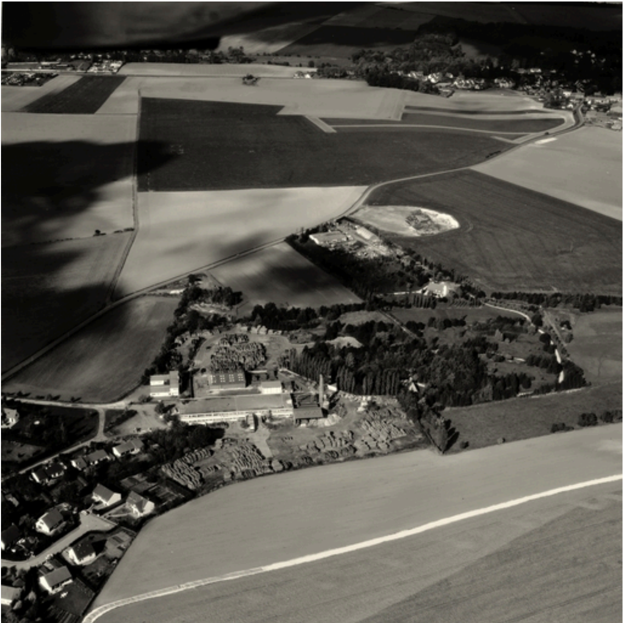
Mesnil-Saint-Laurent : vue aérienne de l'ancienne tuilerie (square de la Tuilerie).
