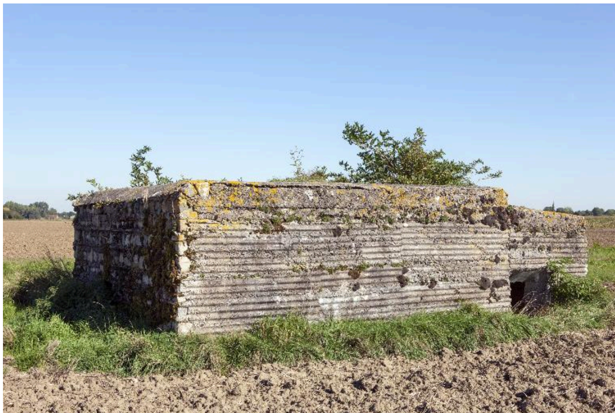
Vue de trois-quarts arrière, vers l'est
