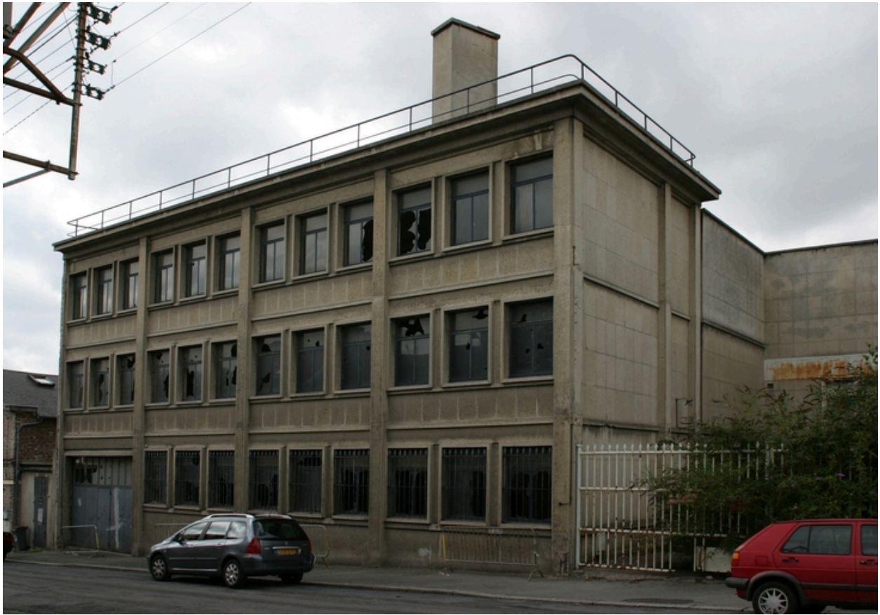
Façade antérieure de la chaufferie, rue Jacquard.
