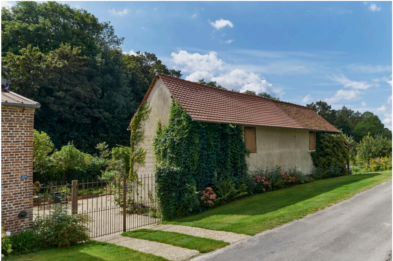
Bâtiment agricole, vue prise depuis le nord-est.
