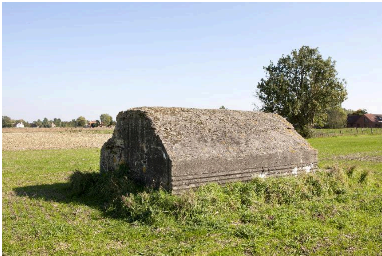
Vue de trois-quarts vers le sud-est
