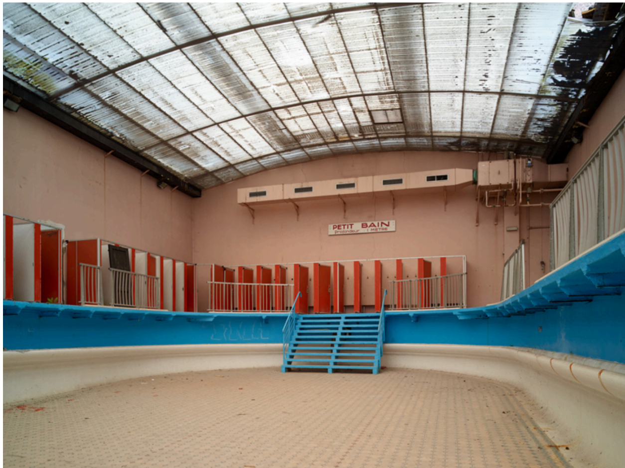
Vue du petit bain, depuis le centre du bassin.
