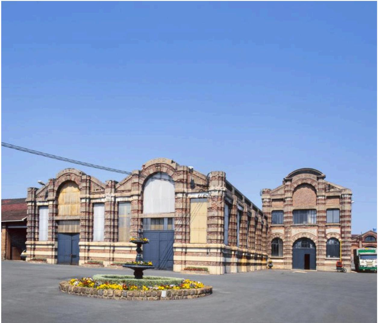
Vue extérieure de l'atelier des modèles situé en face de l'entrée de l'usine et portant la date de 1922.
